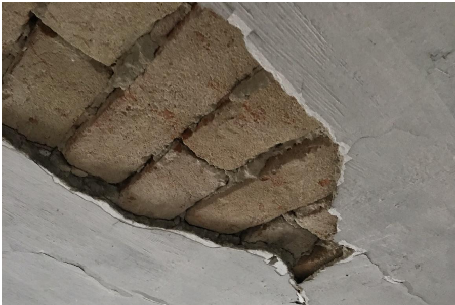
Obr.4 Lokálne opadávanie omietky stropu spôsobené pnutím vzniknutým poklesom severovýchodného nárožia stavby a následným zakrivením roviny stropu. V prípade, že tento proces nebude zastavený, dôjde v neskorších fázach k narušeniu klenbovej väzby a k vypadávaniu tehál zo stropu
