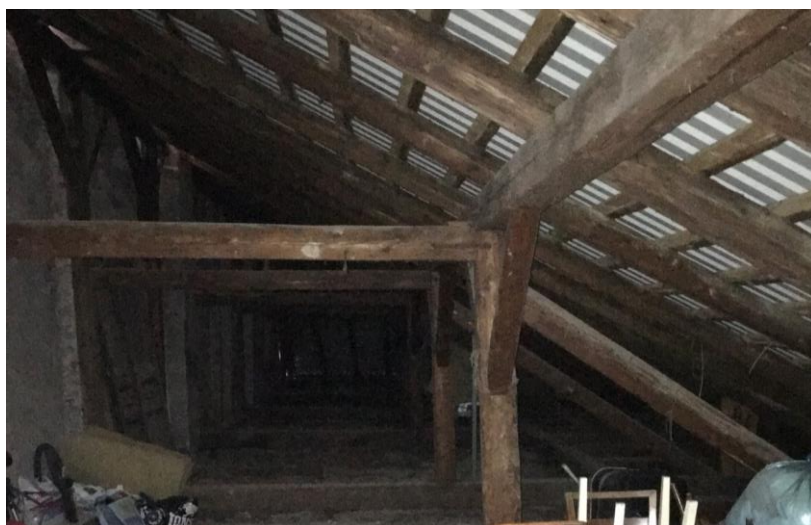
Obr.8 Pohľad na konštrukciu krovu dvorového krídla objektu. Priestor povaly je prístupný iba z exteriéru. V súčasnosti je využívaný iba čiastočne na skladovanie nábytku a nepotrebných vecí. Krov je dlhodobou neošetrovaný, lokálne sa objavujú prehnuté časti.
