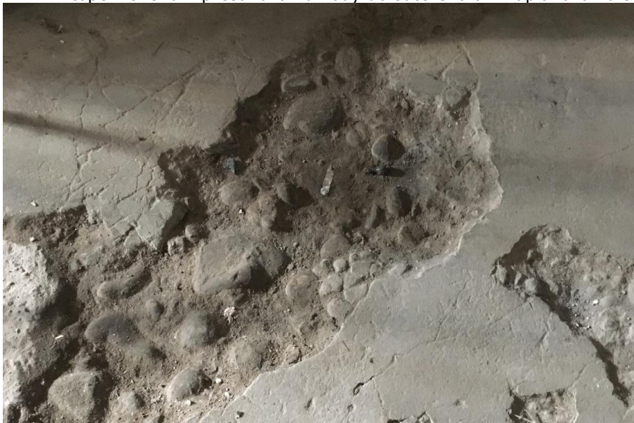
Obr.5 Rozpadávajúci sa podlahový poter suterénu
