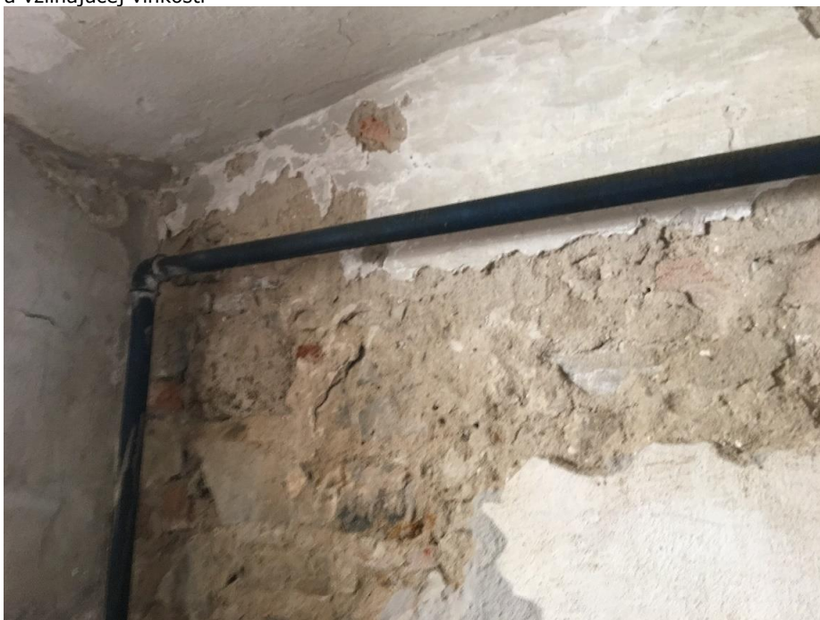
Obr.3 Cez obvodové steny suterénu bez zvislej hydroizolácie dochádza k presakovaniu zemej vlhkosti do interiéru. V zmiešanom murive môže vlhkosť spôsobiť stratu únosnosti plnej pálenej tehly a následné statické poruchy.
