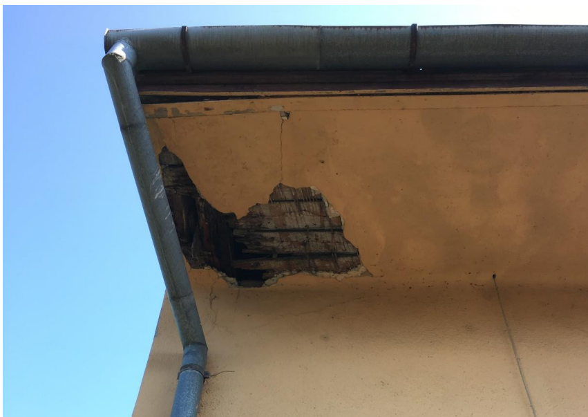
Obr.6 Na obrázku vidno prehnutie krokvy ako aj podbitia presahujúcej časti strechy na južnom konci dvorového krídla objektu. Toto poškodenie vzniká chýbajúcim olemovaním ukončenia pultovej strechy, podtekaním zrážkovej vody pod krytinu, dlhodobým premáčaním dreva, následkom čoho je odhnitie časti nosnej krokvy, prehnutie podbitia a opadávanie omietky. V prípade, že tento proces nebude zastavený, dôjde k pokračovaniu hnilobného procesu dreva na ďalšie prvky krovu a k postupnej deštrukcii strechy v tejto časti objektu.
