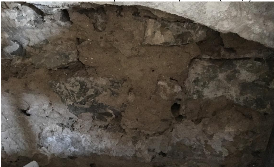
Obr.2 Stav nosného obvodového muriva suterénu spôsobený absenciou hydroizolácie proti zemej a vzliňajúcej vlhkosti
