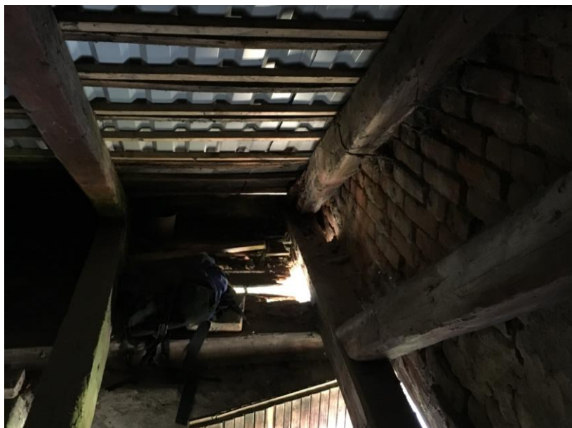
Obr.7 Pohľad na prehnutú konštrukciu krovu spôsobenú podtekaním vody pod krytinu v južnom rohu objektu.
